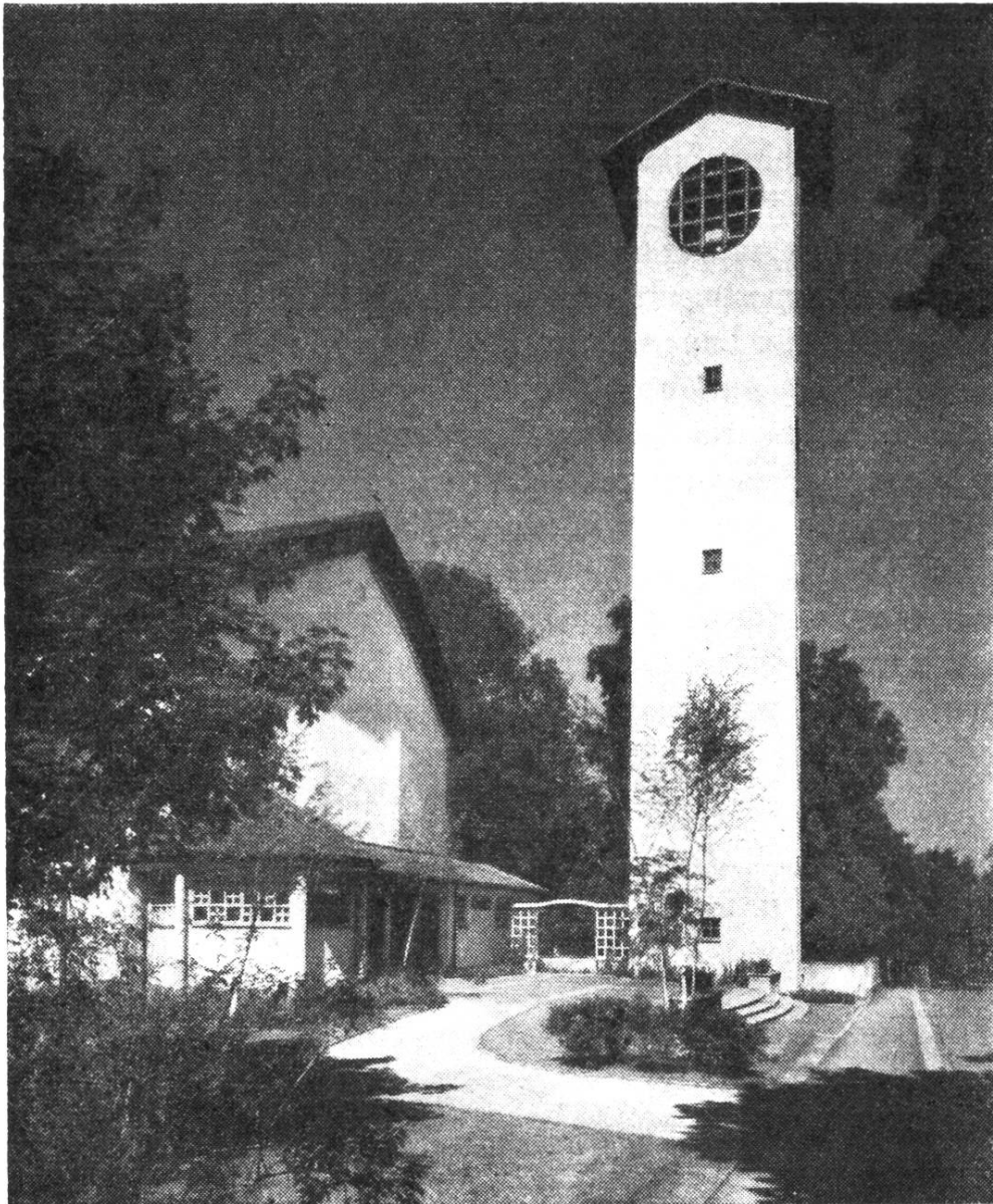
Frei- stehender Glocken- turm mit Kirchen- eingang
