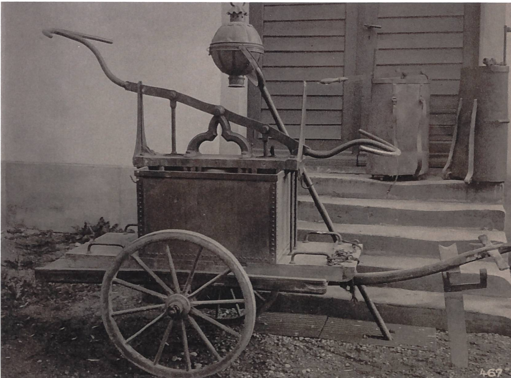
Tragbare Quartier-spritze mit zweifach wirkenden Zylindern Ende 19. Jh.
