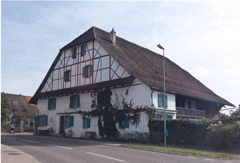
Nordseite des heutigen Gebäudes, an der Strasse von Rümlang nach Watt
