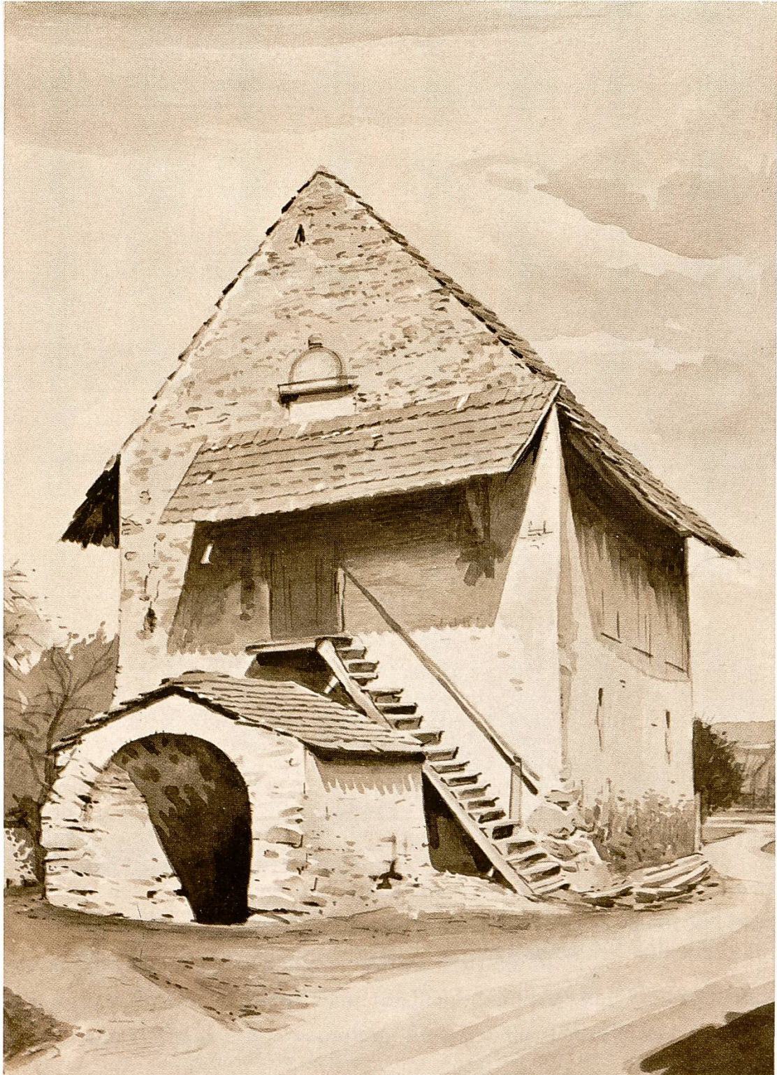
Speicher in Watt bei Regensdorf. Tiefer Kellereingang, über der Türe die Jahreszahl 1670. Die Besitzverhältnisse verteilen sich auf 5 Eigentümer mit 7 Teilrechten.
