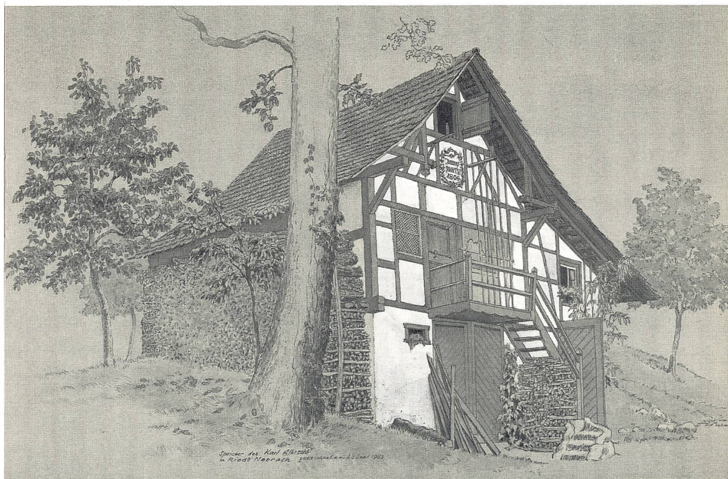
Speicher in Riedt bei Neerach. Im Kranz zwischen den Riegeln die Jahreszahl 1808.
