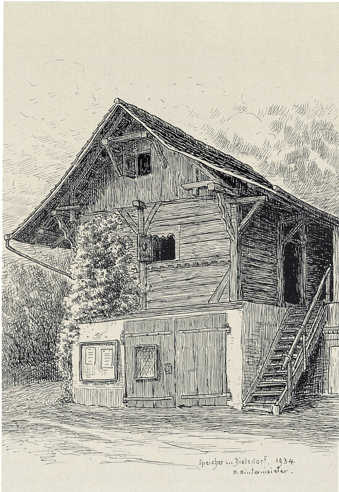
Blockspeicher auf gemauertem Unterbau in Dielsdorf.
