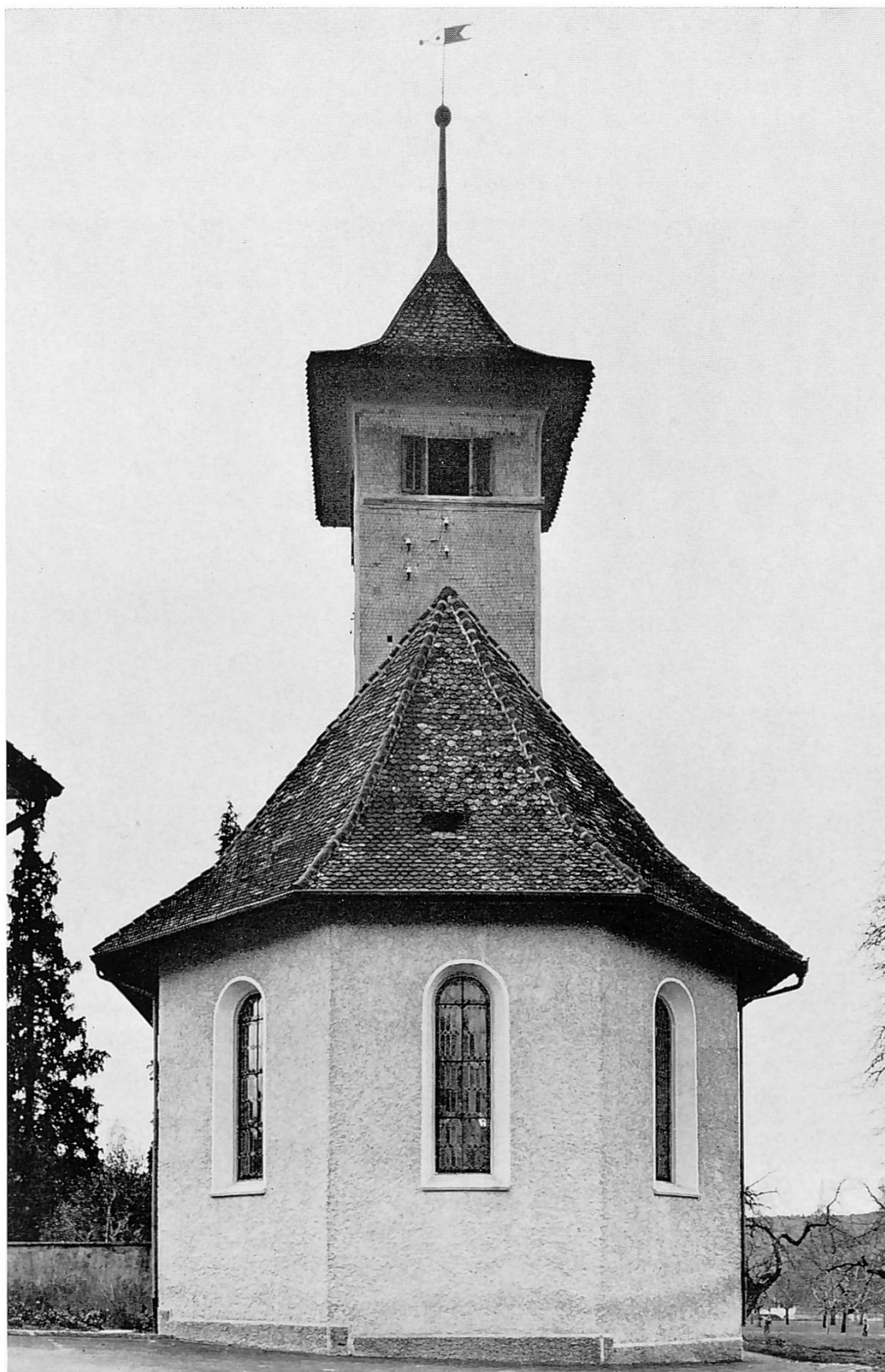
Ansicht der Kirche von Osten
