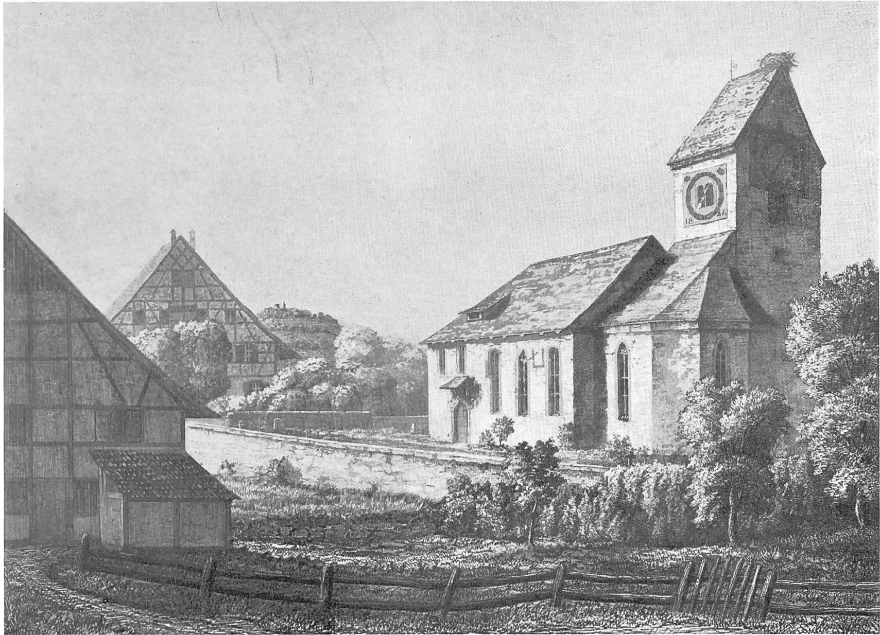
Pfarrkirche in Dielsdorf vor 1865
