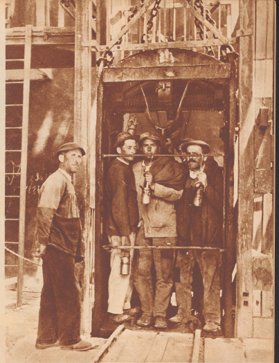
Einfahrt in den Schacht San Agustin. In fünf Minuten Fahrt hält der Förderkorb 372 Meter unter der Erde. So tief ist man bis jetzt in Almadén in die Tiefe gedrungen. Noch immer, wie vor 500 Jahren, ist die Erprobung dieselbe. Zwischen werden Blöcke gefördert, die 34% Quecksilber enthalten.
