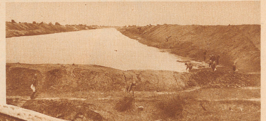
Bewässerungsanlagen in Siam, welche durch einen im Staatsdienst stehenden Schweizer ausgeführt wurden. Durch diese Kanäle konnten große Landstrecken der landwirtschaftlichen Bebauung erschlossen werden
