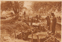
Grabbecken an der Nordwestgrenze. Zum Schutz vor der Sprengwirkung der feindlichen Artillerie- und Handgranateneinschläge wurden die Schützengraben nicht geradlinig, sondern möglichst gewunden gebaut.
