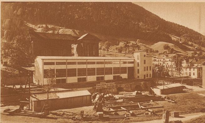
Die Zentrale des Kraftwerkes Sernf-Niederbach in Schwanden mit daranstoßender Freiluftanlage. Die lichtdurchfluteten Maschinenräume beherbergen vier Turbinen von zusammen 37700 PS. Zwei Mann Belegschaft genügen für die Bedienung der ganzen Anlage.
