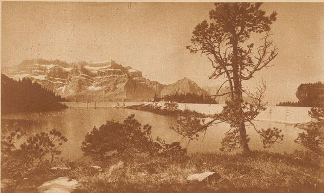
Der Stausee des Kraftwerkes Sernf-Niederbach. Der See liegt 1620 Meter über Meer im Talkessel auf Garichte im Kärpfergebiet und fasst rund 3 Millionen Kubikmeter. Er mußte mit zwei Mauern von 230 m Länge und 36 m Breite bzw. 225 m Länge und 15 m Breite mit zusammen 59 000 Kubikmeter Beton errichtet werden.
