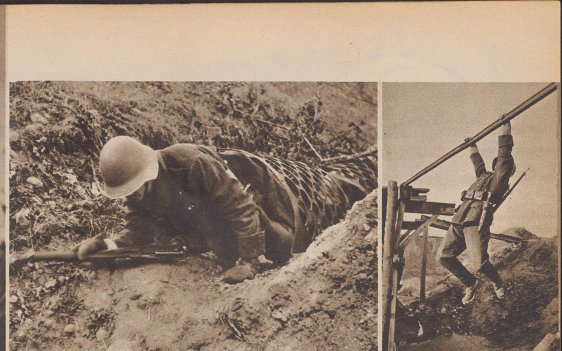
Das Kriechen durch die Röhre. Le rampement à travers les tuyaux. VI Br 6323 An der Eisenschiene hangelnd, muß der Soldat seitwärts von einem Gerüst zum anderen gelangen. Prenant à ses rails, le soldat doit passer latéralement d'un chevalet à l'autre. VI Br 6323
