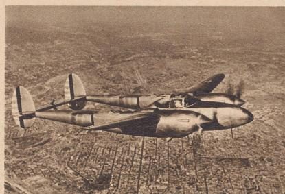
Die «Lockhead P 38», das schnellste amerikanische Kriegsflugzeug. Seine Stundengeschwindigkeit beträgt 700 km, seine Steigfähigkeit 1200 m in der Minute. Die Maschine ist bestückt mit einer Schnellfeuerkanone und vier Maschinengewehren.
