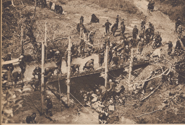
Italienische Pioniertrouppen an der Arbeit bei einem Brückenschlag am Oberlauf des Kalamaflusses. Construction d'un pont sur le cours supérieur du Kalama.
