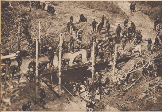
Italienische Pioniertruppen an der Arbeit bei einem Brückenschlag am Oberlauf des Kalamasflusses. Construction d'un pont sur le cours supérieur du Kalamas.
