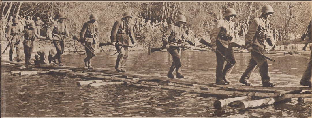
Sappeure haben in der Dichtung des Waldes eine schwimmende Brücke gezimmert, die, nachdem die Stütztruppe die ersten feindlichen Stellungen passiert haben, in den Fluß gebracht worden ist. Auf dem schwimmenden Steg überschreiten nun die Gefechtsgruppen der Kampfkompanien den Fluß. Sous le couvert de la forêt, les sapeurs ont préparé ces passerelles qui permettent aux troupes de choc de traverser rapidement la rivière. III 2256 Ro
