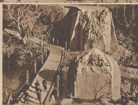
Von den Italienern erstellte Notbrücke über einen Fluß im Epirus als Ersatz für eine von den Griechen gesprengte Betonbrücke.
