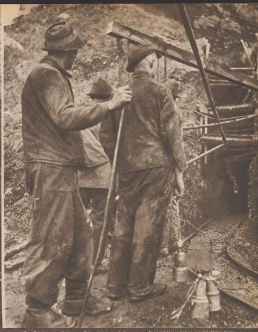
Das Brechen der Konle am Floz erfolgt durch Sprengung. Die führ Hauer haben den füb Meter felen Stollen verlassen und warten darauf, bis eine Sprengladung losgegangen ist. Gegenwärtig werden täglich 15—20 Tonnen gefördert.
