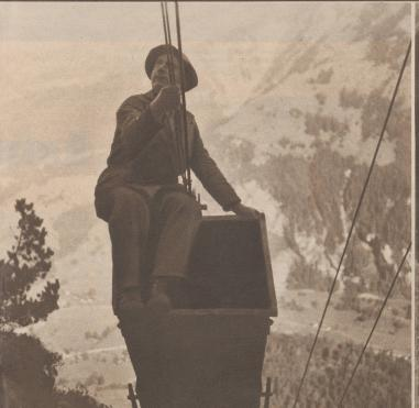
Der Transport der abgebauten Kohle aus den Stollen ans Tageslicht erfolgt mit Rollbshnen, die Beforderung zu Tal mit Hilfe einer Sellschwebebahn. Die schwindelfreien Arbeiter benützen die Sellschwebebahn auch zur Fahrt von und zur Arbeitsstätte. Le charbon extrait de la galerie est chargé sur des wagonnets Decauville puis acheminé vers la vaillée au moyen d'un teléphérique.
