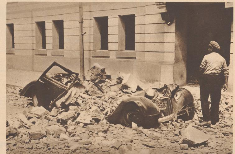
Total zerstörtes Automobil, das vom herabstürzenden Gemüse getroffen wurde. Von diesem Hause wurde das obere Stockwerk vom Beben buchstäblich abgeschüttelt und auf die Erde geworfen, während die unteren Stockwerke und besonders das Erdgeschoss relativ wenig Schaden nahmen. Une automobile écrasée par les pierres d'un immense semi-éboulé.
