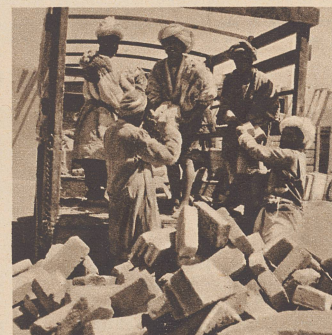
Die Ziegel für die Bauten sind an Ort und Stelle gebrannt worden. Auch der Beton wird in Pol-i-Khomri gemischt, mit Wasser und Kies aus dem Flusse. Der Zement kommt teils aus Rußland, teils aus Indien.
