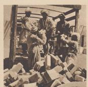
Die Ziegel für die Bauten sind an Ort und Stelle ge-berannt worden. Auch der Beton wird in Pol-i-Khomri gemischt, mit Wasser und Kies aus dem Flusse. Der Zement kommt teils aus Rußland, teils aus Indien.
