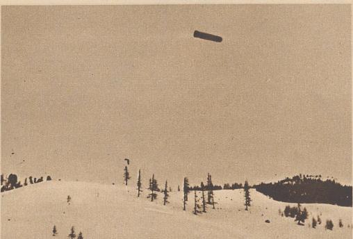
Das Ziel: der von einem Flugzeug nachgezogene Schleppspack. Es wird an einem Stahlkabel von 600–1200 Meter Länge nachgezogen, um Flugzeug und Pilot außerhalb der Gefahrenzone zu halten.
