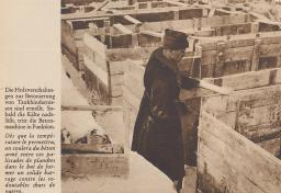
Dès que la température le permettra, on coulera du béton armé entre ces palissades de planches dans le but de former un solide barage contre les redoutables chars de auerre
