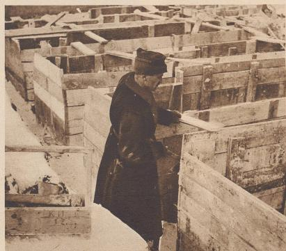
Die Holzverschalungen zur Betonierung von Tankhindernissen sind erstellt. Sobald die Betonmaschine anläuft, tritt die Betonmaschine in Funktion.
