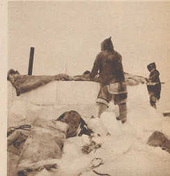
Padleirmiut-Eskimos beim Wohnhüttenbau. Im Gegensatz zu andern Eskimostämmen, die ihren Winterwohnungen eine Kuppel aus Eis aufsetzen, bauen die Padleirmiut und Ahearmiut ihre Iglus mit Flachdach. Dieser Flachdach besteht aus Karibuhäuten.
