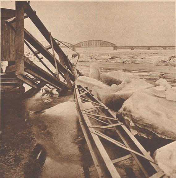
Das Tauwetter, das jetzt eingetreten ist, hat Holland mit richtigen Eislawinen überschüttet. Auf der Maas, dem Waal und dem Lek ist der Eingang so mächtig wie seit 60 Jahren nicht mehr. Blick auf den Waal bei Nijmegen, wo die Eismassen eine Brücke zum Einsturz gebracht haben.
