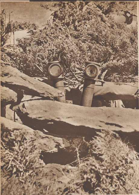
Gut getarnt. Die knapp 30 Zentimeter, die dieses vorzüglich aufgestellte Scherenferrohr aus dem Boden herauswächst, lassen in Verbindung mit der richtigen Rückenmaske diesen Beobachtungsposten nur aus kürzester Distanz erkennbar werden.
