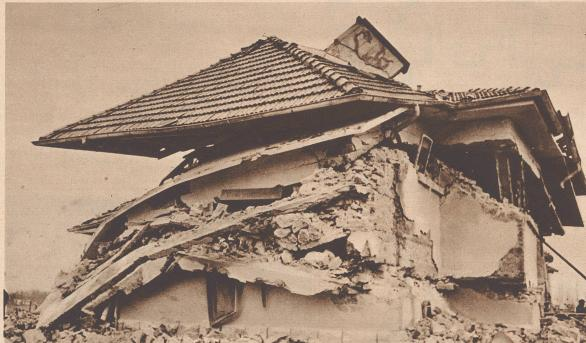
Das Bild des Bahnhofes von Erzindjan zeigt deutlich mit welcher Wucht die Erde erschüttert wurde. Keine einzige Wand dieses vor kurzem erst vollendeten Hauses ist ganz geblieben. Mehrere Bössente fanden unter den Trümmern den Tod.
