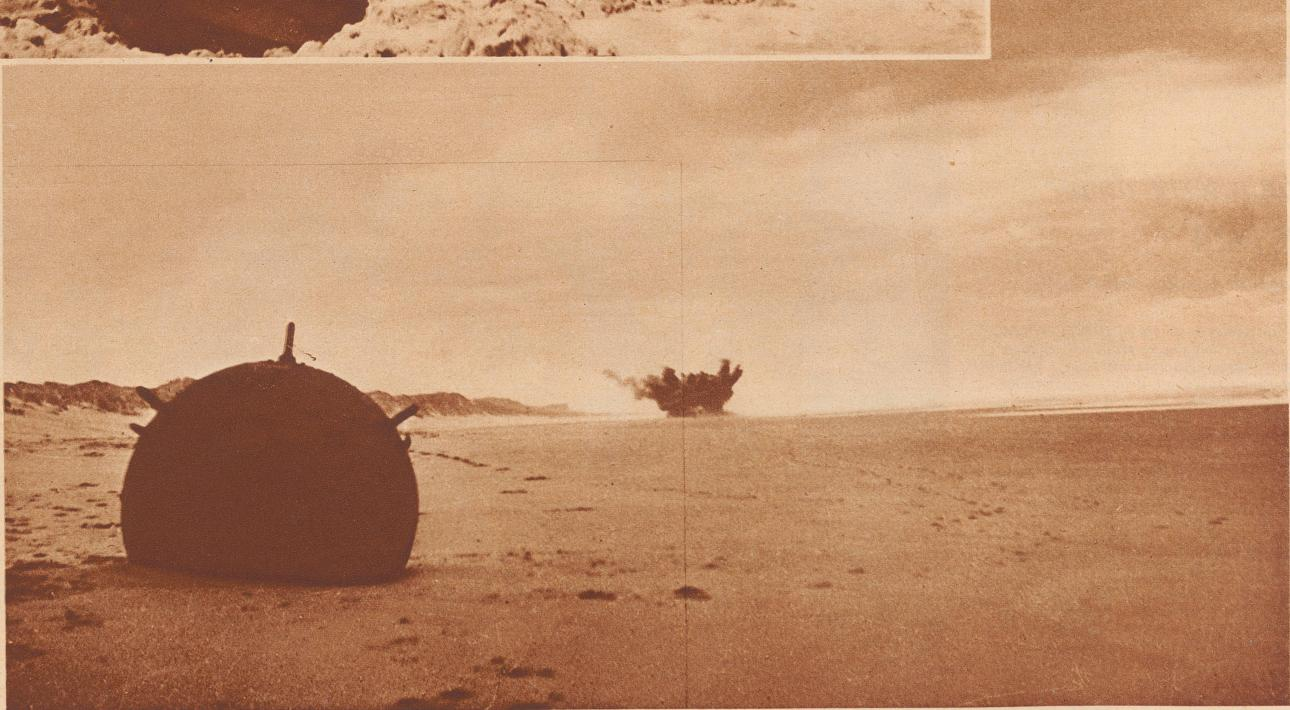
Im Vordergrund eine intakte Mine, die durch sehr geringen Anprall gegen eines der Fühlhörner explodieren und furchtbaren Schaden anrichten kann. Im Hintergrund wird eben eine Mine zur Explosion gebracht und so unschädlich gemacht.
