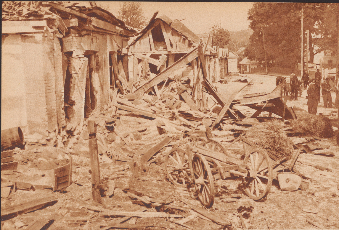
Die Wirkung einer einzigen deutschen Fliegerbombe in Krzemieniec. Sie traf das Haus, wo die polnische Regierung vorübergehend ihren Sitz aufgeschlagen hatte. Das Gebäude, ein leichter Backsteinbau, wurde vollständig in Trümmer gelegt, und auch die Nachbarhäuser wurden vom gewaltigen Luftdruck ganz zerstört oder schwer beschädigt.
