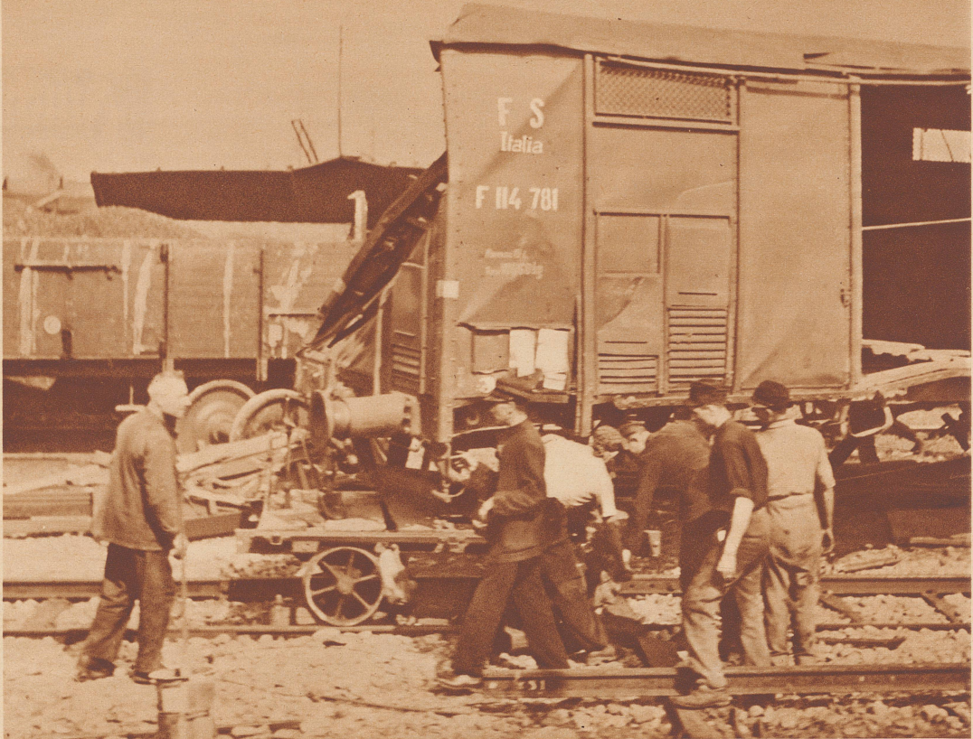
Aufräumungsarbeiten nach der Katastrophe. Der Zug war aus 57 Wagen zusammengestellt. 25 Wagen wurden radikal zertrümmert, 25 andere — wie derjenige auf dem Bilde — wurden stark beschädigt. Vom ganzen Zug blieben nur 7 Wagen intakt.
