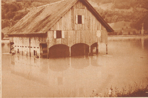
Im Urnerland, zwischen Erstfeld und Altdorf, ereignete sich ein Dammbrech der Reuß, der die ganze Altdorfer Ebene zum Teil über einen Meter unter Wasser setzte.
