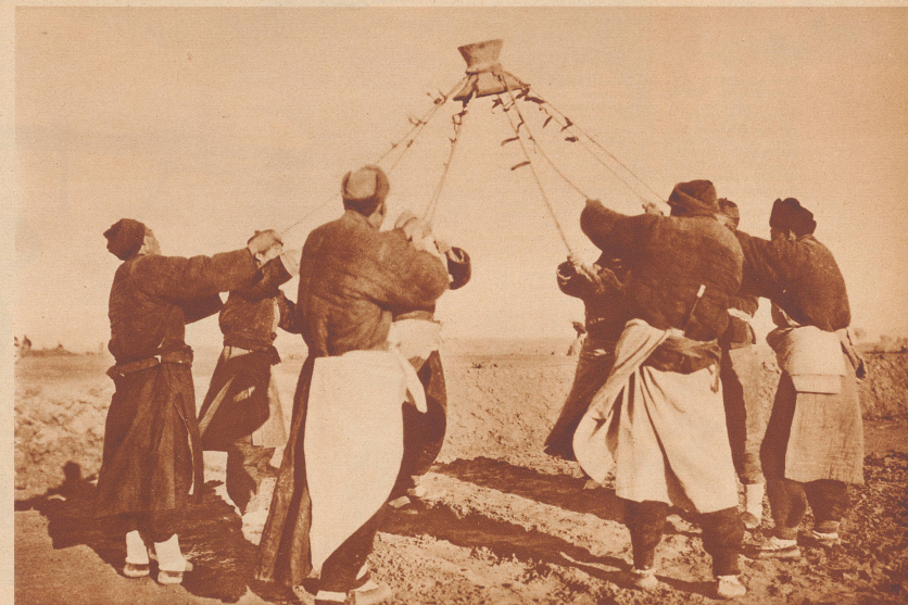
Der »Achtmannschläger« in Tätigkeit. Ein uraltes Instrument, mit dem der Damm »festgewalzt« wird. Acht Mann schleudern den ungefähr 40 Kilo schweren Schläger an 3 Meter langen Seilen in die Luft und lassen ihn auf die Erde niederausfallen. Rund 25 Millionen Kubikfuß Erde wurden so bei diesem Dammbau nicht mit der Dampfwalze, sondern von Hand festgetampft.
