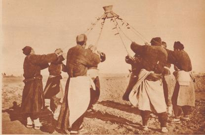
Der «Achtmannschläger» im Tätigkeit. Ein uraltes Instrument, mit dem der Damm «festgewalzt» wird. Acht Mann schleudern den ungefähr 40 Kilo schweren Schläger an 3 Meter langen Seilen in die Luft und lässen ihn auf die Erde niedersausen. Rund 25 Millionen Kubikfuß Erde wurden so bei diesem Dammbau nicht mit der Dampfwalze, sondern von Hand festgestampftr.
