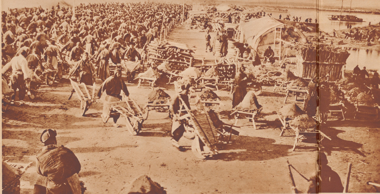
Da kann man schon sagen: es wimmelt wie in einem Ameisenhaufen. Zehntausende von Kulis waren bei diesem Dammbau beschäftigt. Ohne Motorenkraft, ohne andere moderne mechanische Hilfsmittel wird derartige Bauten gearbeitet. Auf primitiven Schubkarren wird alle zum Bau erforderliche Erde herbeigefahren. Rechts eine der Strohhütten, die während des Baus den Kulis als Wohn- und Schlafstätte dienen.
