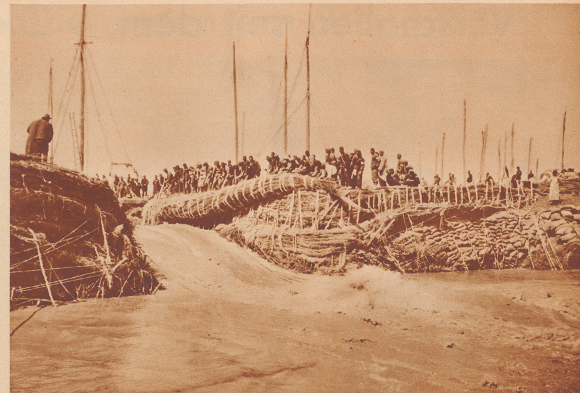
Der Dammbau geht seinem Ende entgegen. Eine Lücke von 10–12 Meter Breite ist noch zu schließen. Mit großer Wucht schießt das Wasser durch die Öffnung; darum ist diese Endphase das schwierigste Stück Arbeit. Eben wird eine der letzten mächtigen Faschinen als sogenanntes Sinkstück ins Wasser gelassen. Diese Faschine ist hergestellt aus 12–15 Meter langen Weiden, ausgefüllt mit Erde und Kies und zusammengehalten mit dicken, auf den Plätze hergestellten Stricken. Zehntausende von solchen Faschinenwürsten wurden bei diesem Dammbau zum Schutze des Lehmkerens benötigt.
