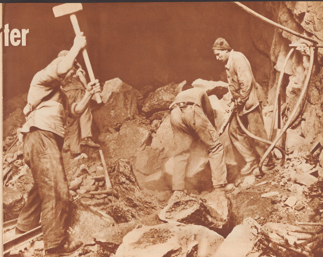
Die Mineure der Sustenstraße-Tunnels am Werk. Die Arbeit ist mühsam in dem harten Fels. Gotthardgranit gehört zum härtesten aller Gesteine. Mit sehr starken Sprengladungen können nur ganz kleine Quantitäten gelöst werden. Le travail est souvent dangereux, il est également pénible. L'humidité suinte des murs et le granit du Gothard est l'une des pierres les plus dures qui soient.
