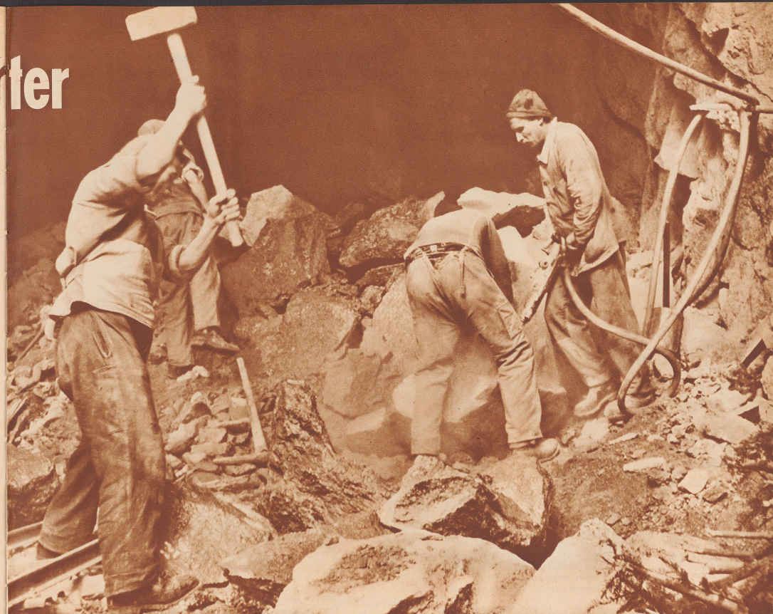
Die Mineure der Sustenstraße-Tunnels am Werk. Die Arbeit ist mühsam in dem harten Fels. Gotthardgranit gehört zum härtesten aller Gesteine. Mit sehr starken Sprengladungen können nur ganz kleine Quantitäten gelöst werden. Le travail est souvent dangereux, il est également pénible. L'humidité suinte des murs et le granit du Gotthard est l'une des pierres les plus dures qui soient.
