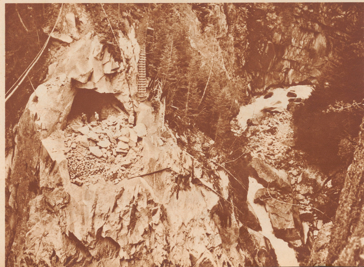
Die Mineure der Sustenstraße-Tunnels am Werk. Die Arbeit ist mühsam in dem harten Fels. Gotthardgranit gehört zum härtesten aller Gesteine. Mit sehr starken Sprengladungen können nur ganz kleine Quantitäten gelöst werden. Le travail est souvent dangereux, il est également pénible. L'humidité suinte des murs et le granit du Gotthard est l'une des pierres les plus dures qui soient.
