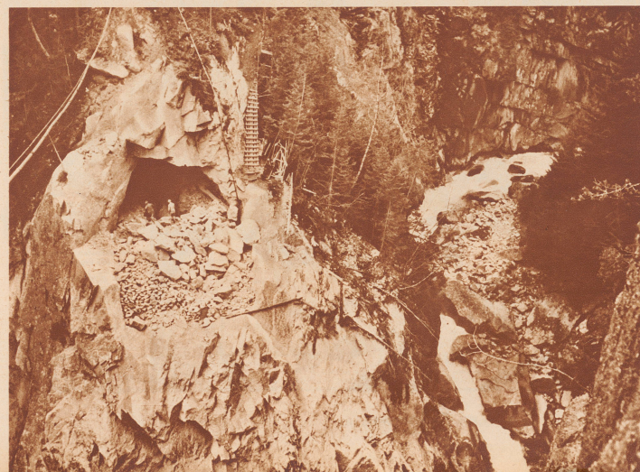
Die Mineure der Sustenstraße-Tunnels am Werk. Die Arbeit ist mühsam in dem harten Fels. Gotthardgranit gehört zum härtesten aller Gesteine. Mit sehr starken Sprengladungen können nur ganz kleine Quantitäten gelöst werden. Le travail est souvent dangereux, il est également pénible. L'humidité suinte des murs et le granit du Gothard est l'une des pierres les plus dures qui soient.
