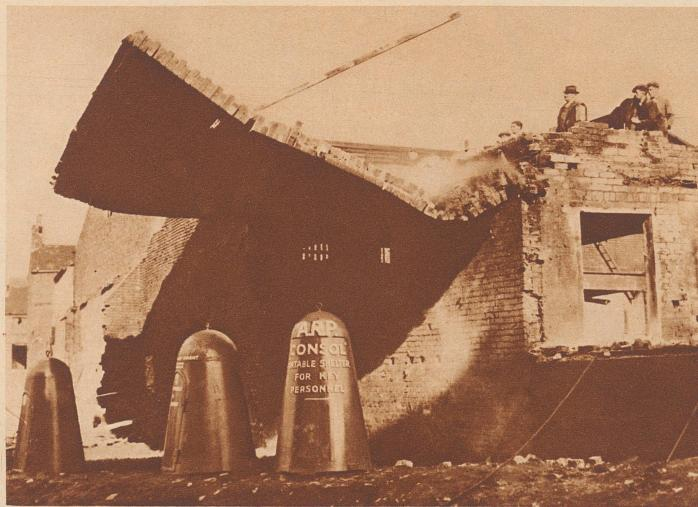
Aehnliches in Birmingham: Eine Anzahl schußfester Luftschutzstahlkegel sollen als transportable Luftschutzräume verwendet werden. Man unterzog sie einer besonders harten Materialprobe unter der Einwirkung eines Abbruchhauses. Schutt und Ziegel stürzten auf die Kegel hinab, die sich jedoch glänzend bewährten und nicht beschädigt wurden.
