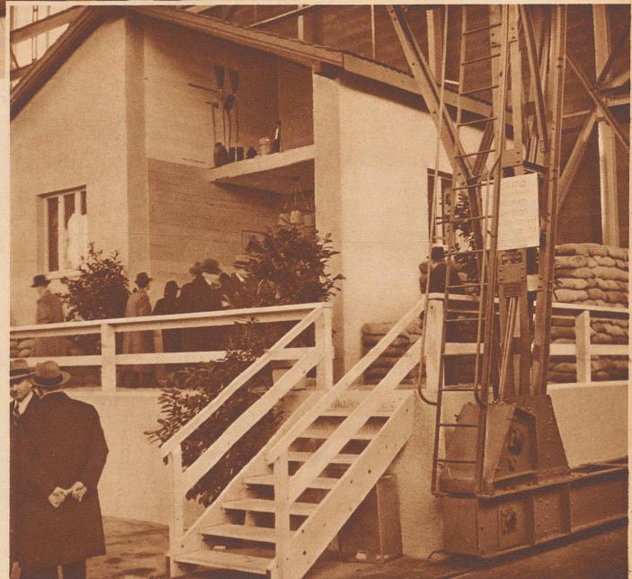
Das Luftschutzhäuschen in der großen Messehalle ist mit einem Luftschutzkeller unter der Stube, mit Schutzzäunen gegen Fliegerangriffe ausgerüstet und ringsum mit Sandsäcken gegen Splitter ge-
