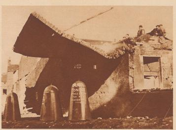
Aehnliches in Birmingham: Eine Anzahl schußfester Luftschutzstahlkegel sollen als transportable Luftschutzräume verwendet werden. Man unterzog sie einer besonders harten Materialprobe unter der Einsturzwand eines Abbruchhauses. Schutt und Ziegel stürzten auf die Kegel hinab, die sich jedoch glänzend bewährten und nicht beschädigt wurden.
