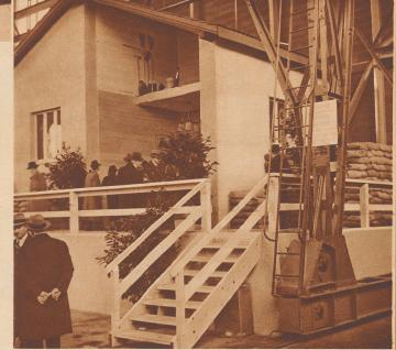
Das Luftschutzhaus in der großen Messehalle ist mit einem Luftschutzkeller unter der Stube, mit Schutzgängen gegen Fliegerangriffe ausgerüstet und ringsum mit Sandsäcken gegen Splitter geschützt. Das Eidgenössische Militärdepartement, die Abteilung für passiven Luftschutz und die Kantonale Luftschutzstelle wirkten an der Erstellung des Luftschutzhauses mit.
