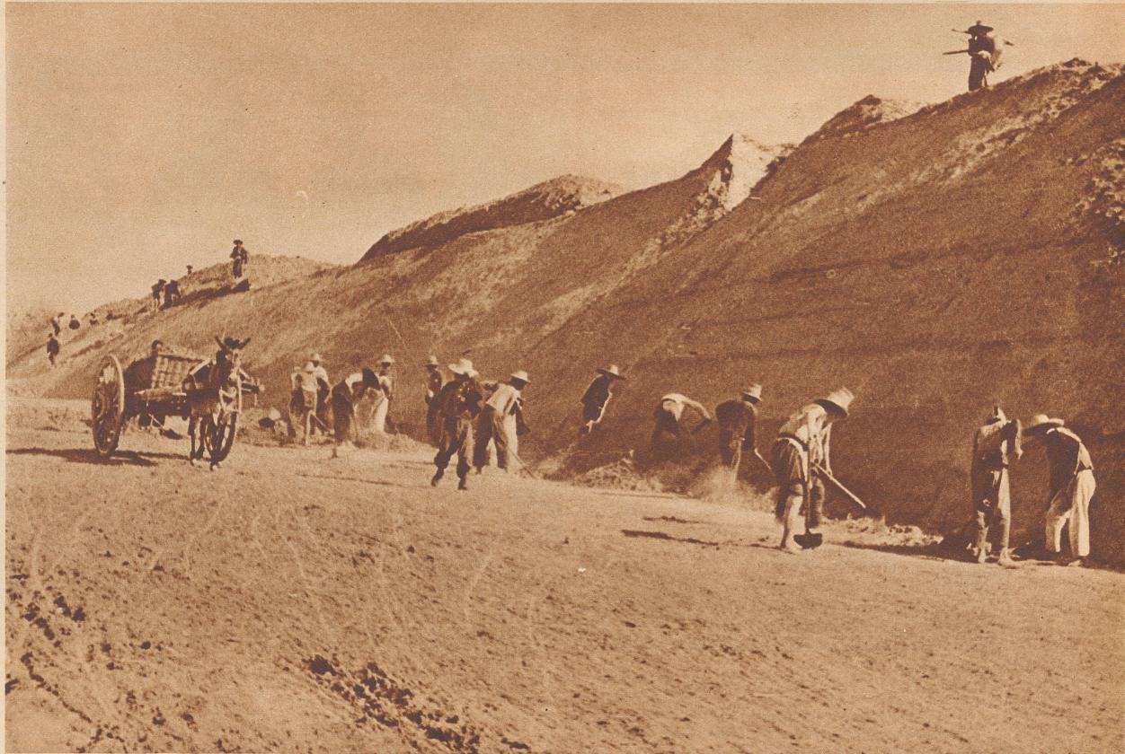
Eine Ausbesserungs-kolonne am Werk. Ohne Straßenwalze und ohne Bagger wird gearbeitet, nur mit Hilfe der alten einheimischen zweirädrigen Pferdekärrnen. Es be steht eine Zweiteilung zwischen Arbeit und Verkehr: morgens 7 Uhr bis abends 7 Uhr wird gebaut. Abends 7 Uhr bis morgens 7 Uhr rollen im Schutze der Nacht regelmäßig die Militär-transporte über die Straße.
