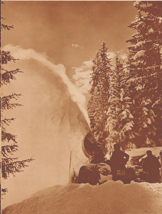
Die erste fahrplanmäßige Abfahrt in Flims-Dorf mit zahlenden Gästen. Man kam auf 45 Leute, statt nur auf 32, wie die Schlitten eigentlich fassen. Aber der Motor mit seinen 80 PS überwand alle Schwierigkeiten. Er heizt mit seinen Auspuffgasen den Schlittengängen die Füße. Deutlich sieht man das gebogene Leitungsrohr vom Traktor zum ersten und vom ersten zum zweiten Schlitten gehen. Die Schlitten sind ganz aus Metall mit Holzsitzen. Le départ de Flims. 45 passagers ont pris place dans ce premier convoi. Canalisés par un système de tuyaux — que l'on voit entre les traîneaux — les gaz du moteur de 80 HP du tracteur sont utilisés pour chauffer les pieds des usagers.
