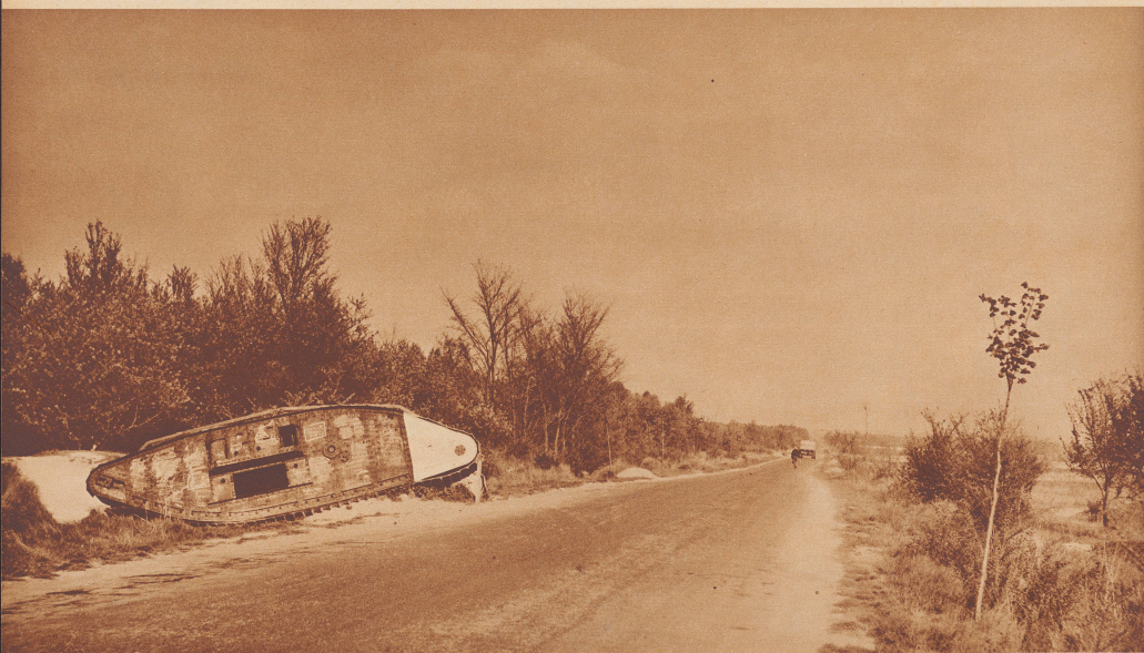
Der Tank am Straßenrand
