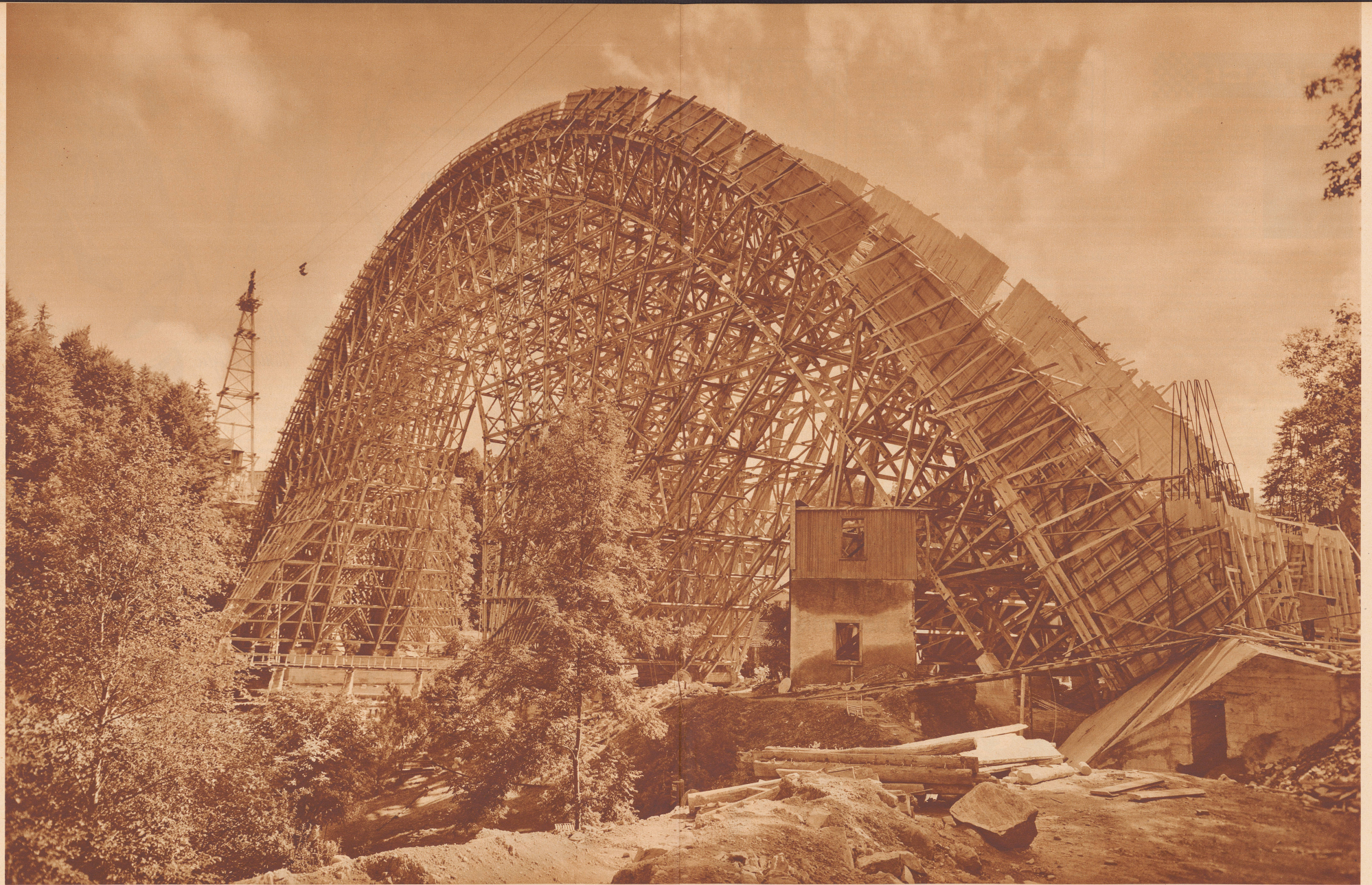
Der große Bogen. Das ist das mächtige Fächergerüst aus Holz, das zum Bau des weitgespannten Bogens der neuen Sitterbrücke bei St. Gallen erstellt werden mußte. Diese Brücke, die der Erleichterung des Zugangs von Westen zur Stadt St. Gallen dienen soll, wird die größte Straßenbrücke Europas in Eisenbeton sein. 135 Meter weit und 60 Meter hoch wird der Zwillingsrippenbogen das Sitterobel überspannen. Die ganze Länge der Brücke beträgt 550 Meter, die nutzbare Breite 14 Meter. 6000 Cantions Kies und Sand, 400 Eisenbahnwagen Zement, 4000 m 3 Gerüstholz, 1120 Tonnen Armierungsstahlgewärbe werden für den Bau der Brücke benötigt. Die Bauzeit dauert drei Jahre, während welcher Zeit ständig 50–100 Arbeiter Beschäftigung finden. Die Baukosten belaufen sich auf 3 450 000 Franken.
