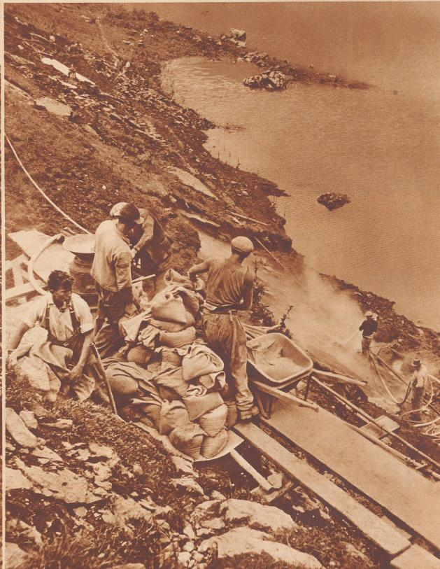
Wie tiefe Wunden ziehen sich lange Risse durch den zerklüfteten Kalkstein. Durch diese kann das eindringende kalte Wasser leichter Zementinjektionen können hier den Schaden wieder gutmachen. Anfang des Jahres hatte ein Kapuzinermönch auf Bannalp mit einer Wünschelrute das Seebecken nach undichten Stellen abgetastet.
