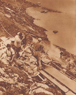
Bei der Abdichtung. Oben füllen sie Zement in die Misch-maschine; in der Tiefe steht der Mann, der das Material unter Druck gegen das durchlässige Gestein spritzt.
