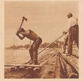
Bei Bischberg unterhalb Bamberg wird das Floß zusammen-gestellt, eine Arbeit, die mehrere Täge in Anspruch nimmt. 500 Fichtensthämme werden mittels Querbülzern und 18-cm-Nägeln verbunden. Die entrindeten Stämme bilden drei Lagen übereinander. In Kubikmetern ausgefürdick sind das 280m<sup>14</sup>folz.
