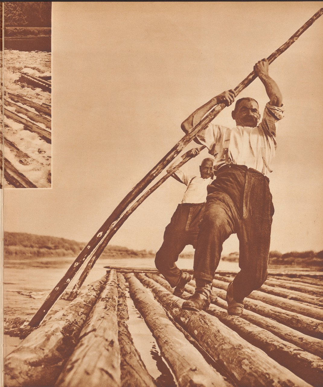
Im Tempo von 30 bis 40 Stundenkilometer schwimmt das Floß den Main hinunter. Mit ihren 6 Meter langen Flößerstangen, Staaken genannt, halten zwei Leute das Floß beständig in der Steuerung, versuchen jegliches Scheuern der Ufer zu vermeiden und steuern das Floß elegant um die Mainwindungen und zwischen den Brückenhochs hindurch. Diese Arbeit, die beträchtlichen Muskelaufwand und große turnerische Geschicklichkeit erfordert, nennt man: Floßen.
