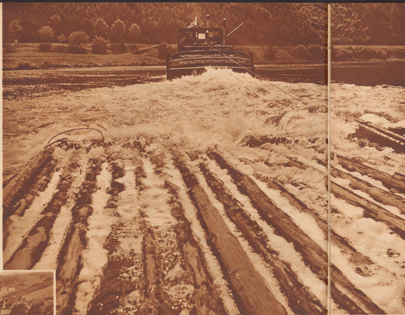
In seinem Unterlauf wird der Main breiter, tiefer und langsamer. Deshalb vollzieht sich die zweite Hälfte der Reise von Lohr bis Mainz im Schlepp eines Motorschiffes der Mainschleppschiffahrtsgesellschaft. Die Geschwindigkeit beträgt nur 8–10 Kilometer pro Stunde. Le Main s'élargit, son cours devient plus calme, aussi fait-on remorquer le train flottant par un bateau de tonnage allant à 10 kilomètres.
