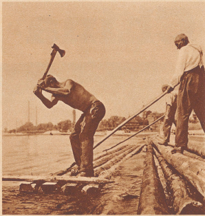
Bei Büschberg unterhalb Bamberg wird das Floß zusammen- gestellt, eine Arbeit, die mehrere Tage in Anspruch nimmt. 500 Fichtenstämme werden mittels Querhölzern und 18-cm- Nägeln verbunden. Die entrindeten Stämme bilden drei Lagen übereinander. In Kubikmetern ausgedrückt sind das 280 m³ Holz. A Büschberg, on arrime le train de bois. Opération difficile et qui prend plusieurs jours. Le radeau est constitué par trois couches superposées de troncs qui sont assemblés par des traverses fixées par des clous de 18 cm.
