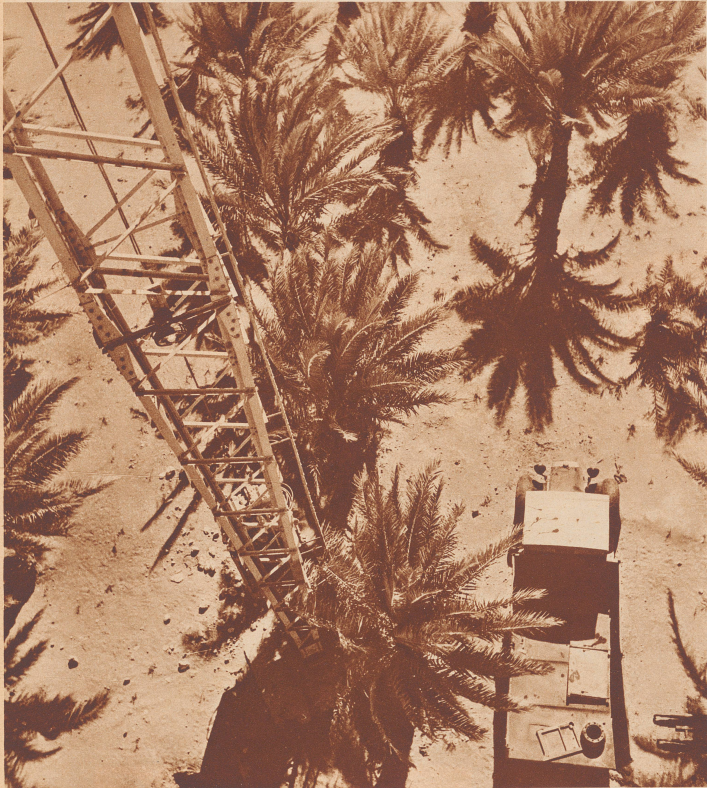
Zum Überqueren der vier großen Wasserläufe Euphrat, Tigris, Jordan und Orontes wurden die Leitungen entweder in Abseht eingepackt, ins Flußbett versenkt oder an hohen Eisenkonstruktionen über die Flüsse geführt. Ersteres ist beim Jordan und beim Orontes der Fall, letzteres beim Euphrat und beim Tigris. Das Bild zeigt, mitten in den Palmen stehend, einen 40 Meter hohen Leitungsträger bei Haditha am Ostufer des Euphrat, wo die Rohre auf eine Distanz von 600 Meter frei in der Luft hängen.
