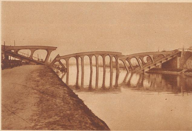
**Brückeneinsturz.** Wahrscheinlich infolge eines Konstruktionsfehlers ist die kürzlich erbaute Brücke über den Albert-Kanal bei Hasselt in Belgien eingestürzt, als eben ein Tram darüberfahren war. Menschen kamen nicht zu Schaden.
