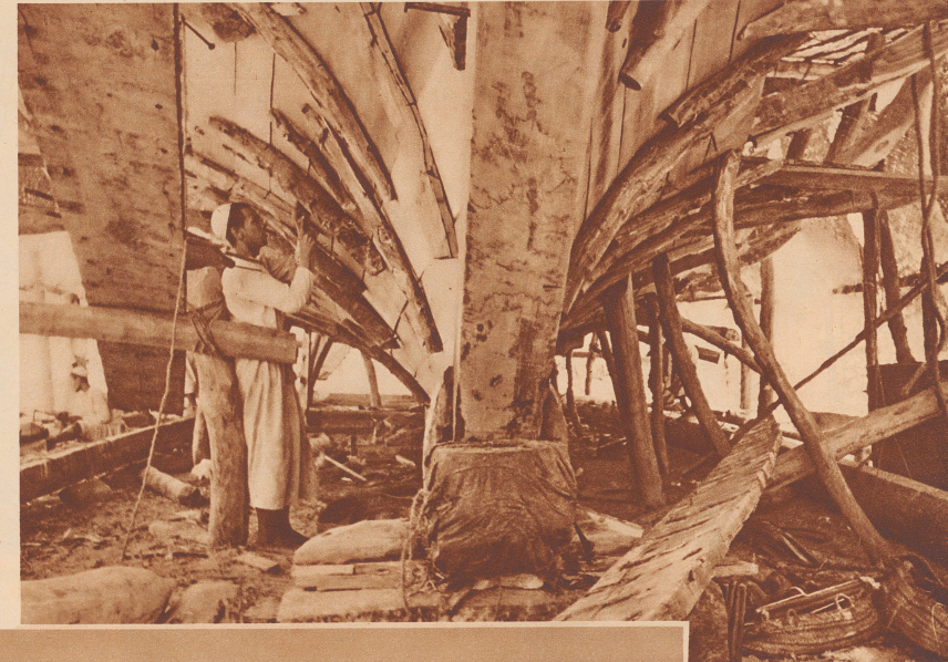
Arabische Boote im ersten Baustadium. Schon zeichnet sich der Rumpf des Dreihunderd-Tonnen-Seglers ab. Die Innenwand des Schiffes wird verschalt.
