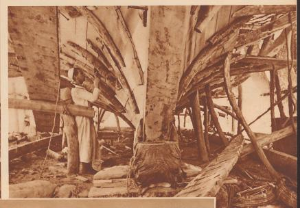
En chantier, voici la co-que intérieure d'un boutre de 300 tonnes.
