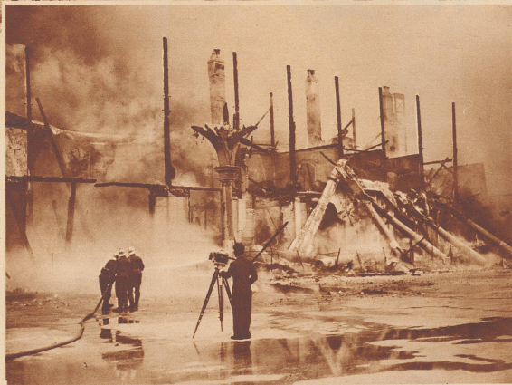
Blick auf die Riesenbrandstätte Freitag, den 17. September, 2 Stunden nach Ausbruch des Feuers. Le vendredi 17 septembre. Deux heures après l'incendie monstre de la Rotonde de Vienne.
