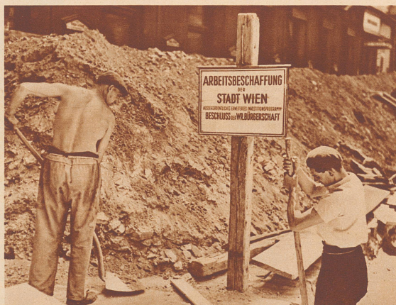
Arbeitsbeschaffung auf der Großstadt-Straße
