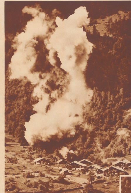
15 Sekunden später. Die Sprengung ist vollzogen. Der Block ist geborsten. Mit dumpfem Gepolter stürzen die Felsmassen über die in eine dichte Staubwolke gehüllte 200 Meter hohe Wand zu Tal. Mancher Baum fällt der steinigten Lawine zum Opfer. Den gefährdeten Häusern auf dem Meisiboden, die vorsichtigerweise vor der Sprengung geräumt worden waren, geschah nichts. Nur ein paar faustgroße Sprengstücke rollten in ihre Nähe, und einige kleine Steine fielen auf die Schindeldächer.
