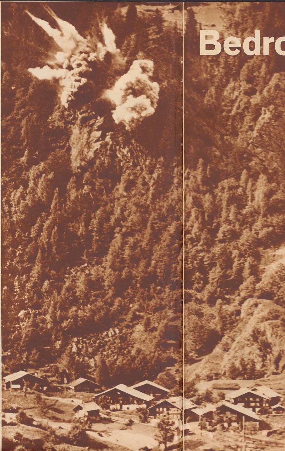
Der große Augenblick. Am 9. August, punkt 16 Uhr, wurde die Ladung — 240 Kilogramm Telnit — durch elektrische Zündung zur Explosion gebracht. Eine Detonation, ähnlich dem Krepiieren einer 200 kg Fliegerbombe, war im ganzen Tal mit dutzendfachem Echo hörbar.
