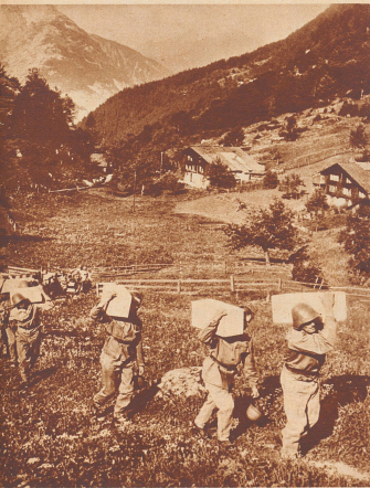
Le bloc d'environ 900 mètres cubes qui menaçait de s'effondrer sur les maisons de Meisiboden. Au pied du bloc, deux mineurs en cordés foront la roche en différents endroits pour y mettre les charges, de façon à ce que le bloc soit pulvérisé par l'explosion.
