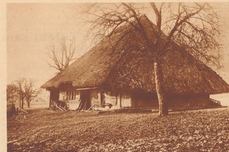
Im argauischen Kirchlennau steht ein uraltes Strohhaus, das wegen Baufälligkeit demnächst abgerissen werden soll. Die Wohnräume, eine Stube mit zwei Nebenräumen und Küche, stecken mit Stall und Scheune unter demselben Strohdach. Es war dem Heimatschutz leider nicht möglich, dieses Haus, eines der selten gewordenen Strohhäuser im Argau, für die Nachwelt zu erhalten. Defekte Strohdächer dürfen übrigens nicht wieder mit Stroh erneuert werden, sie müssen gemäß baupolizeilichen Verfügungen ihre Blößen mit modernen Ziegeln decken. Quelle merveille paysanne que cette ferme au toit de chaume de Kirchlennau (Argovie). On parle pourtant de la détruire, car elle présente des dangers d'effondrement.
