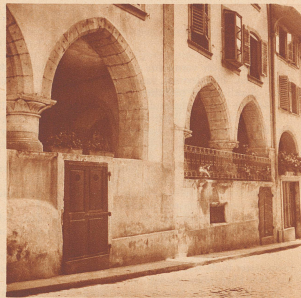
Schöne frühgotische Erdgeschosse- laube an Bürgerhäusern in Estavayer. De belles arcades d'un gothique primitif orient les maisons bourgeoises d'Estavayer.
