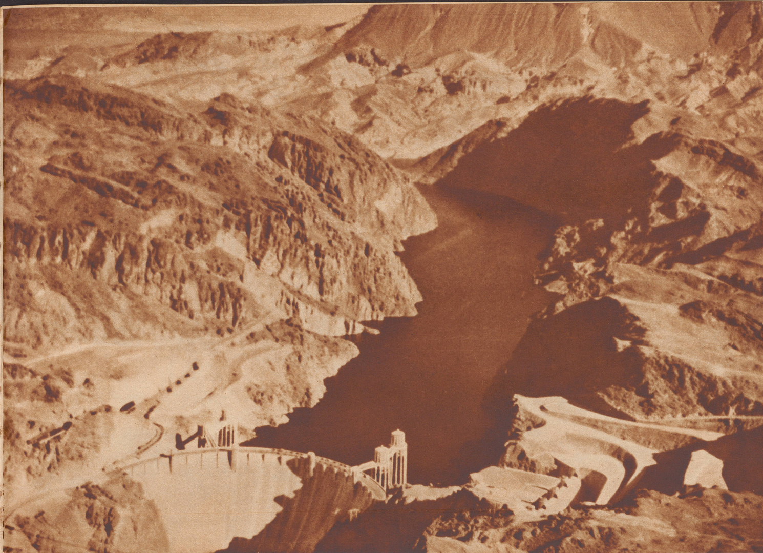
Der Boulderdamm, 400 Kilometer nordöstlich Los Angeles, aus 1000 Meter Flughöhe. Der größte Staudamm der Welt wurde vor zwei Jahren fertiggestellt. Er ist 400 Meter breit, verbindet die Staaten Arizona und Nevada und staut den Colorado-River auf 200 km aufwärts. Durch die Stauung ist der größte künstliche See der Welt, mit einer Oberfläche von rund 6000 km 2 (1/7 des Flächeninhaltes der Schweiz) entstanden. Die gestaute Wassermasse produziert 1 835 000 PS. und dient zugleich zur Bewässerung von Südkalifornien und zur Urbarmachung großer Wüstengebiete.
