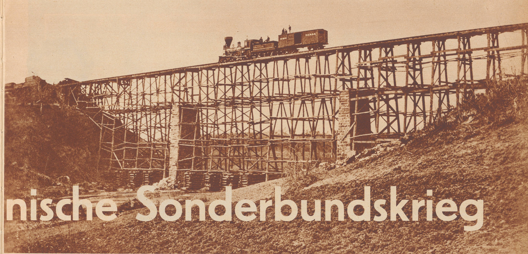
Eine Eisenbahnbrücke über den Potomac. Die Pioniersoldaten der Nordstaaten erbauen diese Brücke in neun Arbeitstagen. Die Errichtung solcher Brücken spielte eine wesentliche Rolle in der militärischen Strategie des Nordens. Un pont de chemin de fer sur le Potomac, élevé en neuf jours par les soldats du génie. La construction de semblables ponts joua un rôle important dans la stratégie des Nordistes.
