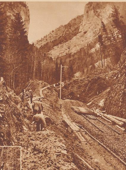
Blick in die enge Klus von Court mit einem Teil der Verheerungen des Erdrutsches. Auf eine Län von 300 Meter ist das Bahntrasse mit mächtigen Felsblöcken, Schutt und Bäumen meterhoch verschütte Wo das noch möglich war, wurde in aller Eile das Geleise abmontiert.
