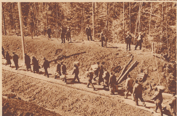
Beidseitig verkehren noch Personenzüge bis zur Unfallstelle. Dort wird der Verkehr durch Umsteigen aufrechterhalten. Ungefähr 300 Meter müssen die Reisenden zu Fuß gehen. Der Gütertransport auf der Linie aber ist ganz eingestellt.
