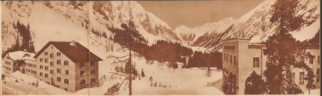
Hier in den Maschinen-Werkstätten neben der Zentralfabrik Linhard, Wytensbaum-Lautner und die «Schneebahn», welche die Handeck 11 Familien y passent l'hiver isolés du reste du monde. Le chemin de fer souterrain leur sert depuis dix ans pour aller à Guttannen.
