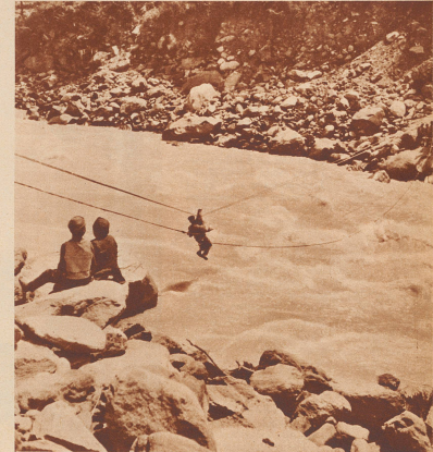
Kitziger Uebergang eines Eingeborenen über den wilden Kaligrenzfluß in das abgeschlossene Nepal. Der Passant hängt an einem Holzblock am oberen Seil und wird vom Ufer aus an einem unteren Seil an gegenüberliegende Ufer gezogen. Un sports primitif sur le Kali. L'indigène est assis sur un bloc de bois suspendu à la corde supérieure. Avec la corde inférieure, il se meut vers la rive opposée.
